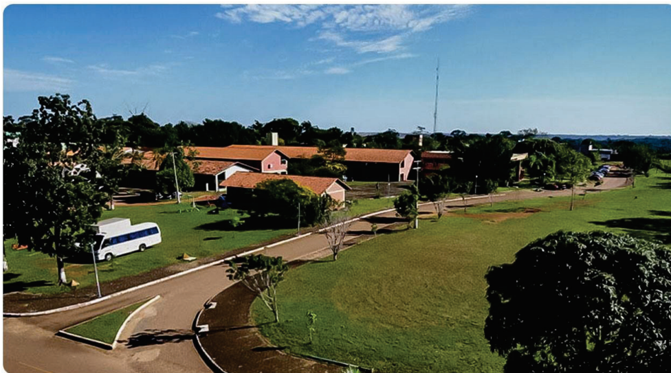
Figura 11- Vista aérea do Câmpus de Porto Velho
