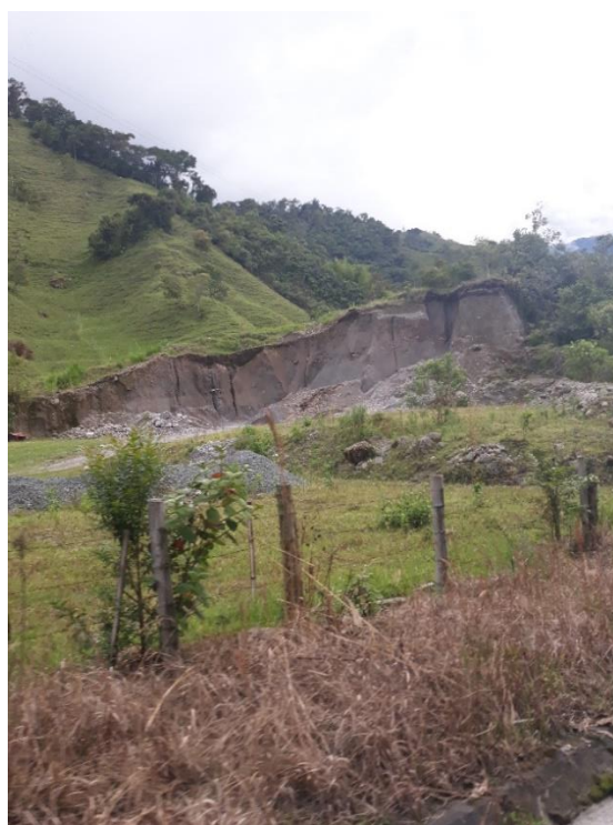
Figura 12. Foto arenera 2 - tomada 16/05/2018 Fuente: captura propia
