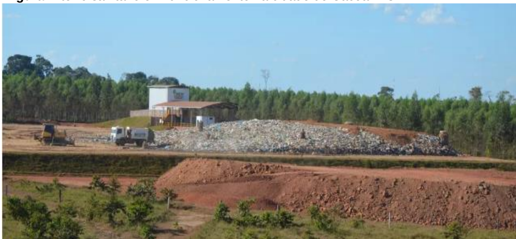
Figura: Aterro sanitário em funcionamento na cidade de Cacoal-RO.
