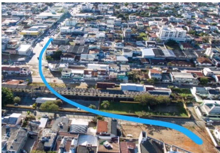
Figura 08 – Vista aérea do prolongamento da Quarta Avenida de Balneário Camboriú. A linha azul indica o novo traçado e prolongamento da via.
