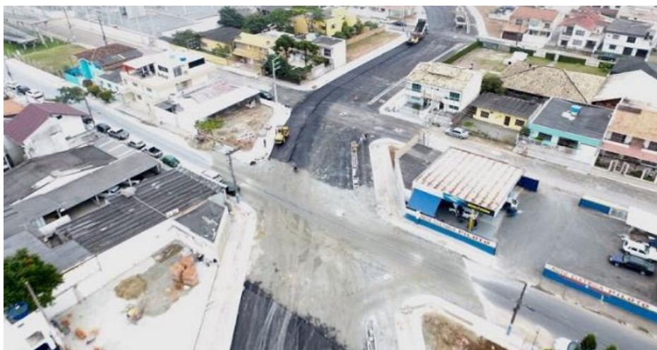
Figura 10 – Vista aérea da Quarta Avenida após começo das obras.
