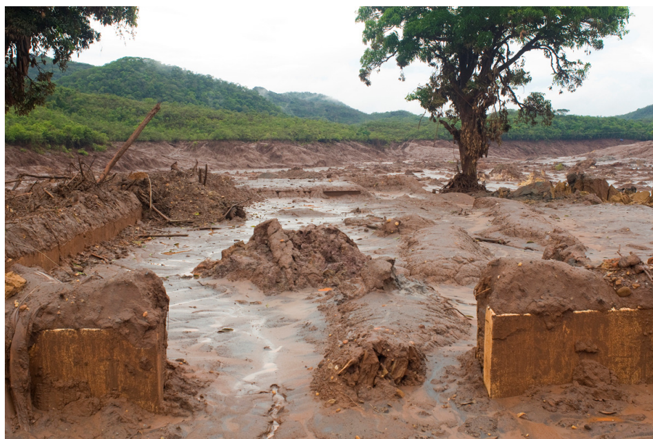
Figura 2: Foto pós-rompimento. Local onde ficava a edificação da Fachada Principal. Igreja de São Bento
