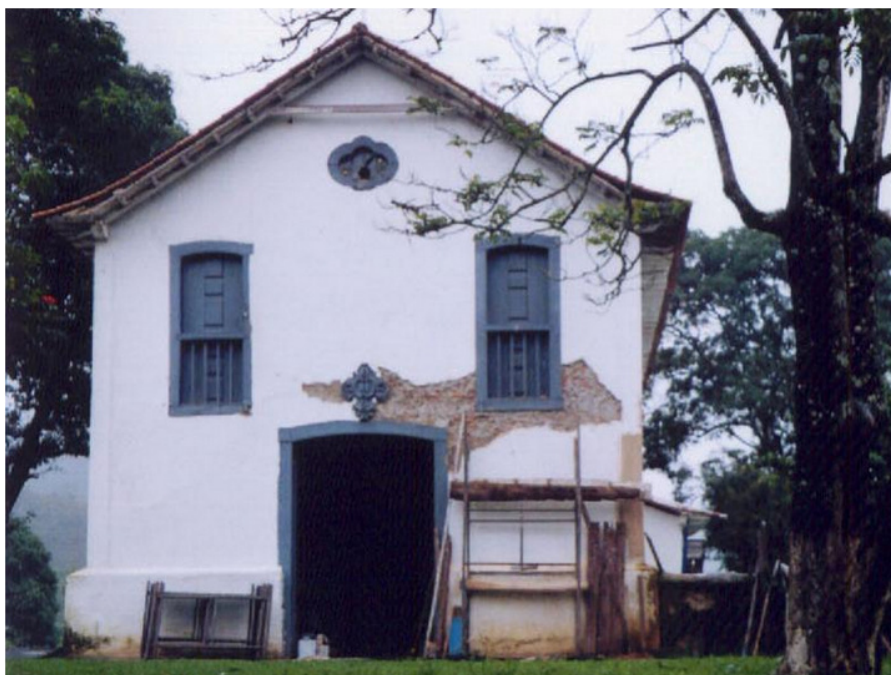
Figura 1: Fachada Principal. Igreja de São Bento
